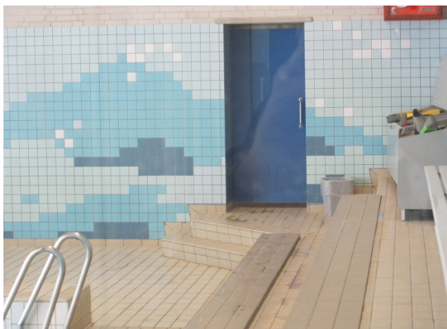
Trappe ned til svømmehallen
