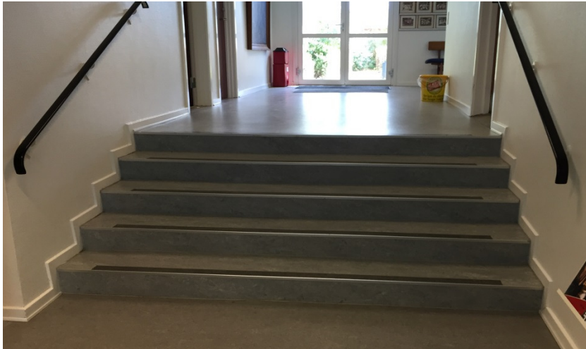
Trappe i vestlig fløj fra 1961
