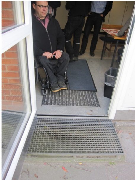
Udgangsdør ud for fysiklokalet
