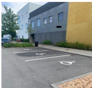
Handicapparkeringspladser foran sundhedscentret
