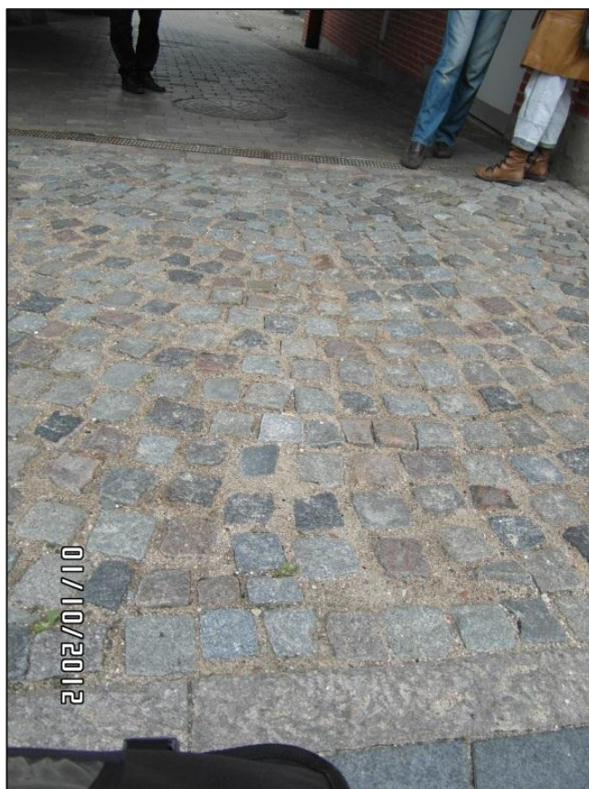
Fig. 16 – Brostensbelægning på Nygade ved overgangen til Casinotorvet
