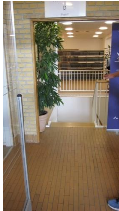
Trappe over for indgangsdøren til biblioteket i bygning 1351
