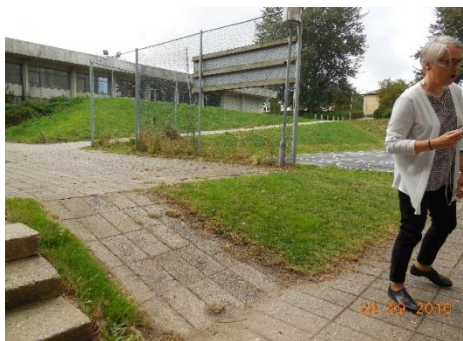
Rampen op til udendørspladsen ved teatersalen
