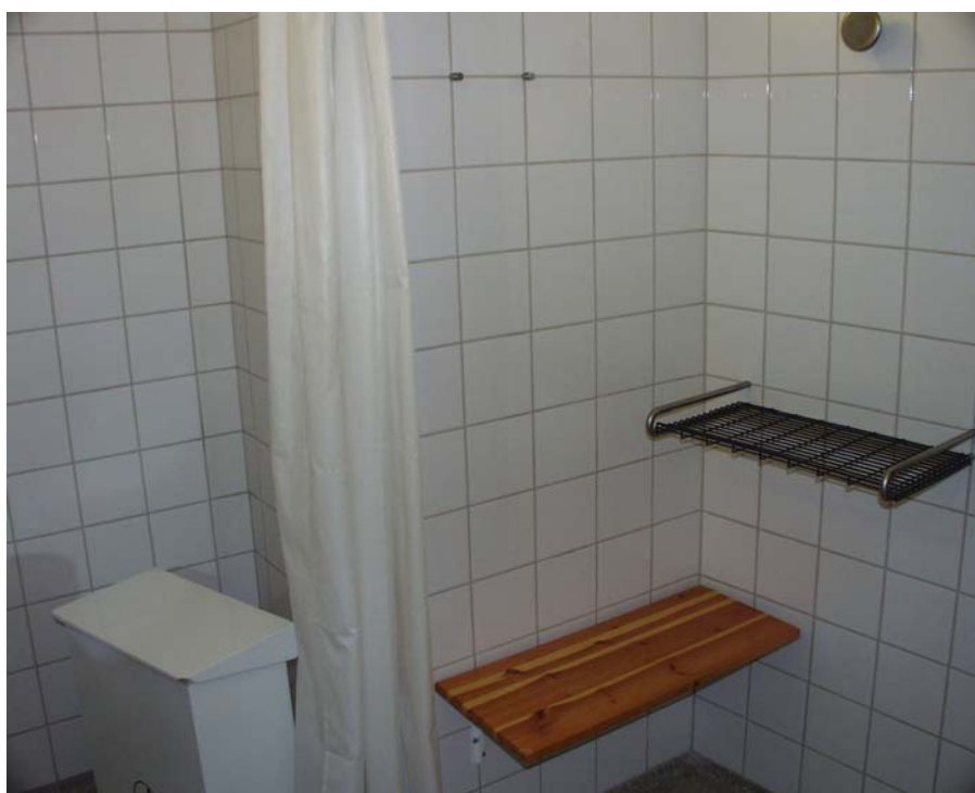
Illustration 17. Bænk og hylde på handicappedtoilet
