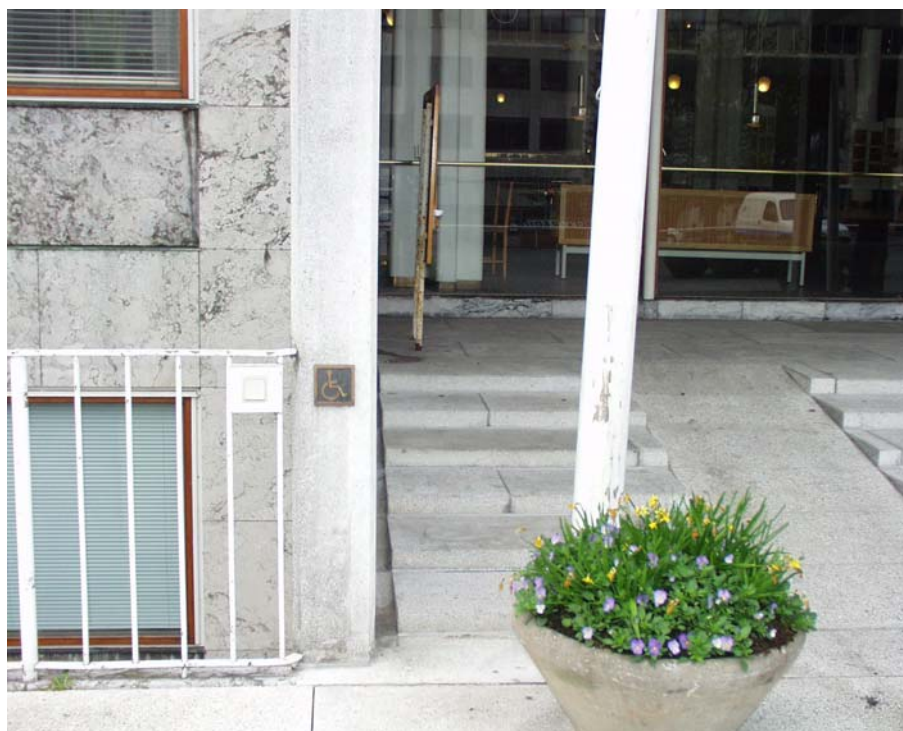
Illustration 4. Tilkaldeknop og rampe ved hovedindgang
