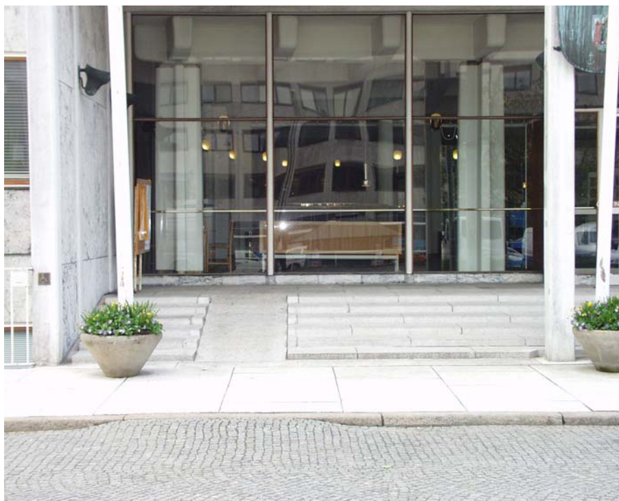
Illustration 3. Hovedindgang med trappe og rampe
