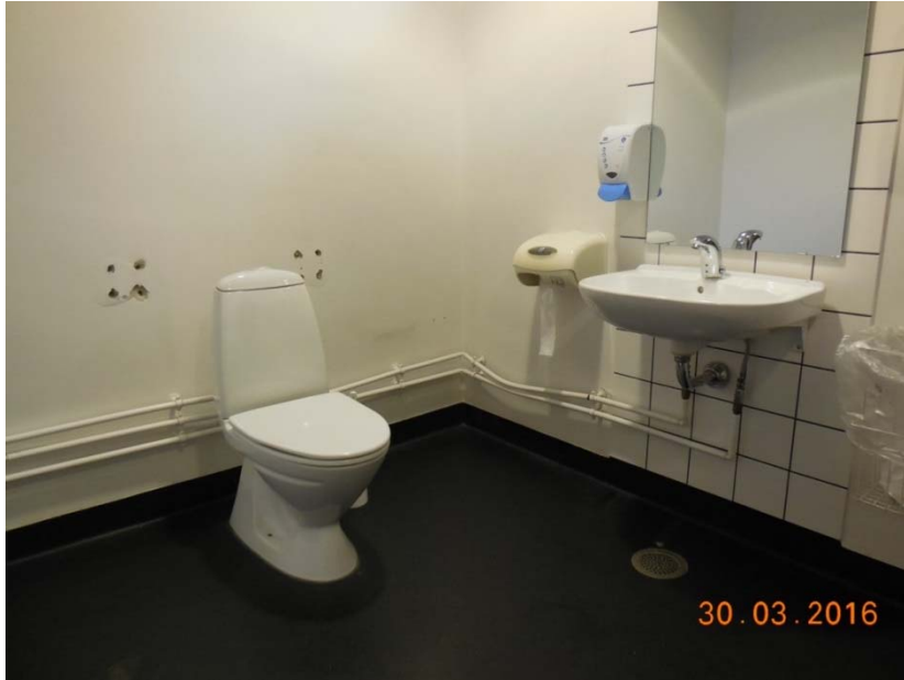
Handicappedtoilet i kælderen i udskolingen (lokale 7.3)
