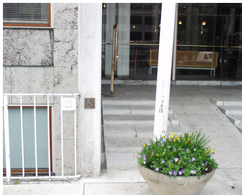
Illustration 4. Tilkaldeknap og rampe ved hovedindgang
